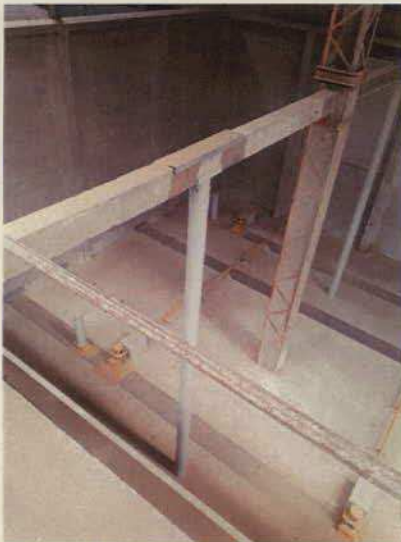
Dessin 1: Renforcement des poutres
